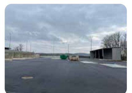
Avancée des travaux à la déchetterie
