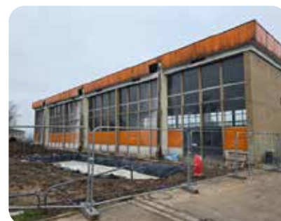
Poursuite des travaux au gymnase
