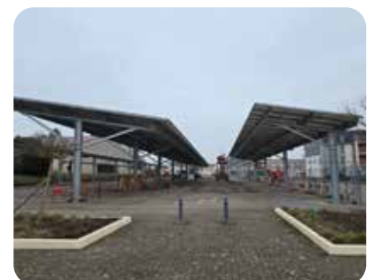
Début des travaux d'installation d'ombrières au complexe sportif
