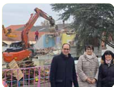
Démolition de l'ancien péricolaire
