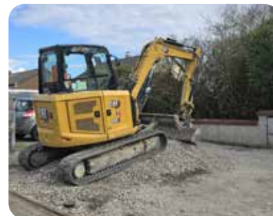
Réfection du parking rue de Copenhague
