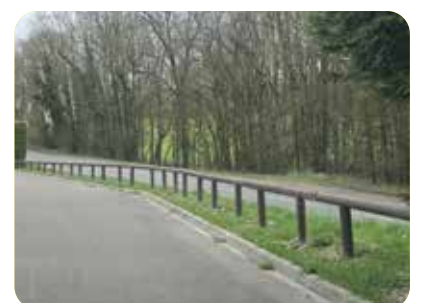
Installation de rambarde rue Debussy
