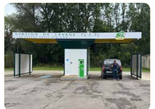
Reprise de la station de lavage par l'entreprise Gallet
